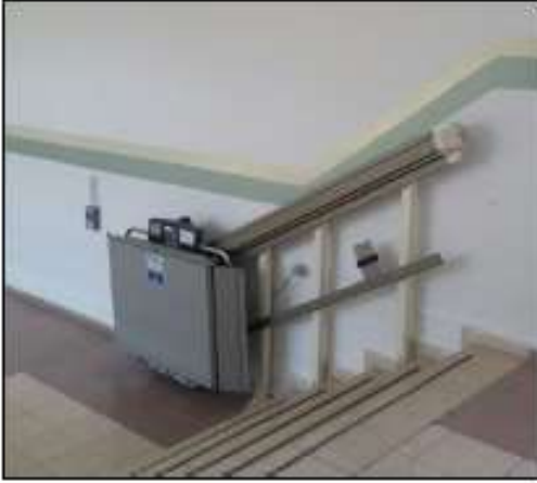
Şekil 3. Kat aralarındaki engelli asansörü
